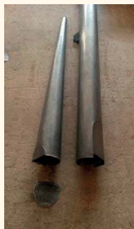
Canna di facciata in fase di restauro
